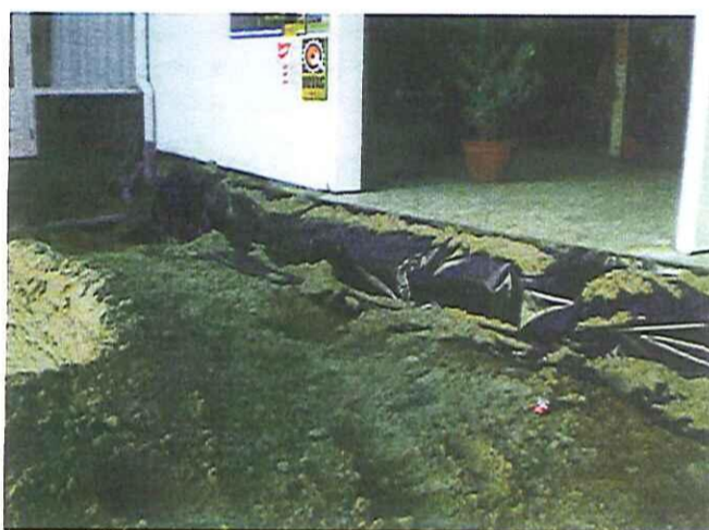
Tijdens de sanering konden de werkzaamheden doorgaan, maar Leo Hoeben heeft de zaak bewust een week gesloten.
